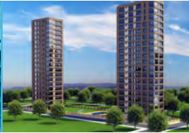
Teknik Yapı Coşkan Sitesi Mekanik Tesiisat
