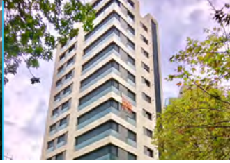
Narin Palas Pan İnşaat Suadiye Mekanik Tesiisat
