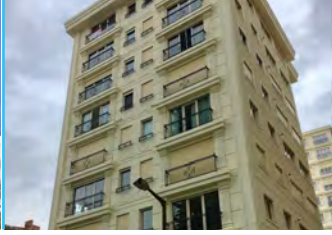
Taif Yapı Erenköy Mekanik Tesiisat
