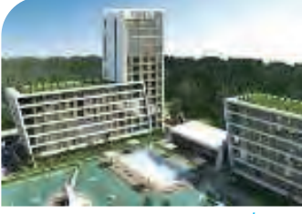
Teknik Yapı Evora Park Tuzla / İst. Mekanik Tesiisat
