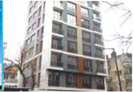
Telliöğlü İnşaat Kızıltoprak Projesi Mekanik Tesiisat
