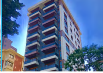
Evrım Apt. GO Yapı Fenerbahçe Mekanik Tesiisat
