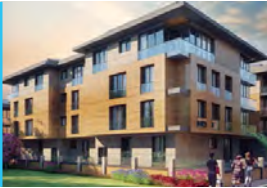
Teknik Yapı Suadiye Sahil Projesi Mekanik Tesiisat
