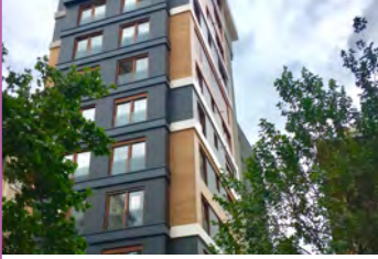
Akçam Apt. GO Yapı Erenköy Mekanik Tesiisat
