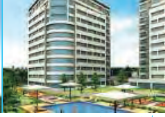
Teknik Yapı Upcity Residence Kartal / İst. Mekanik Tesiisat
