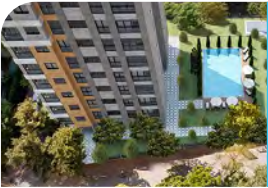
Teknik Yapı Seben Apt. Suadiye Mekanik Tesiisat
