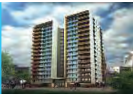
G&O Yapı Maya Aptm. Fenerbahçe / İst. Mekanik Tesiisat
