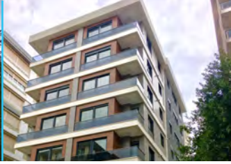
Yuvam Apt. GO Yapı Fenerbahçe Mekanik Tesiisat
