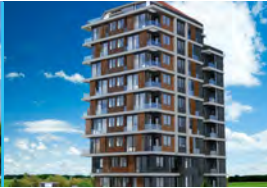
Sarp Yapı Suadiye Projesi Mekanik Tesiisat
