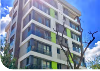
GN Yapı Maltepe Mekanik Tesiisat
