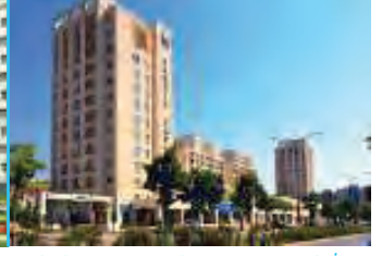
Teknik Yapı Upcity Flats Center Kartal / İst. Mekanik Tesiisat
